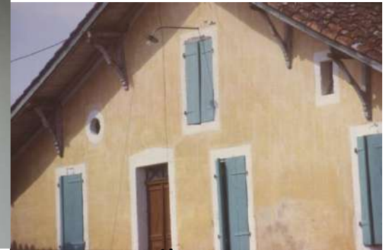
Consoles de bois en support d'avant-toit
