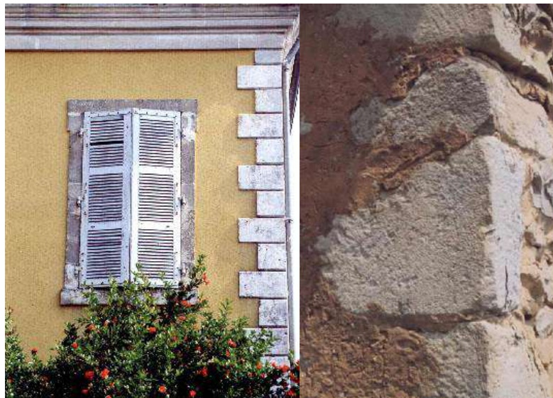
chaînages d'angle en pierre
