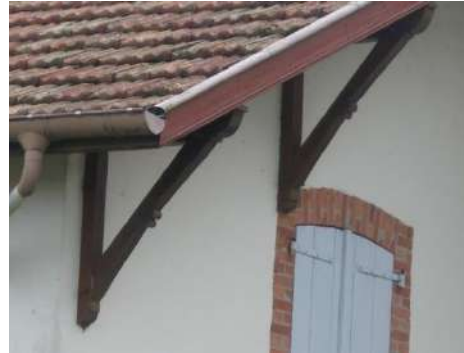
Consoles de bois en support d'avant-toit
