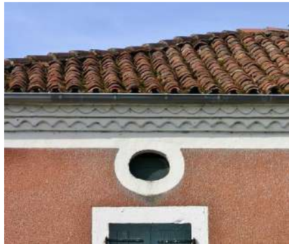
Génoise ou corniches
